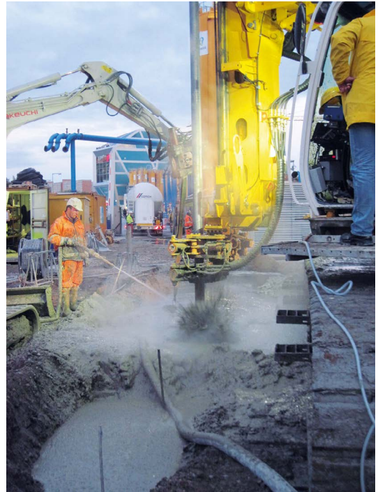
Sohlabdichtung | Sealing slabs
