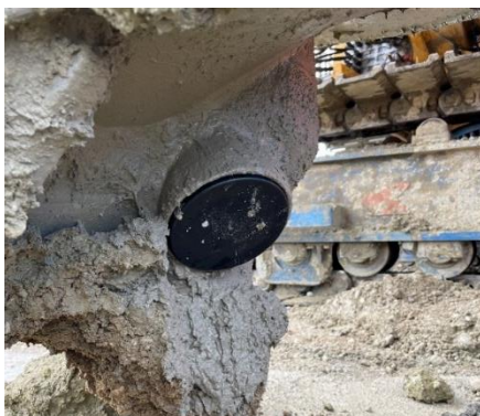
Abbildung 2: Einweg Betonaustrittsdeckel Standard, eingeschlagen
